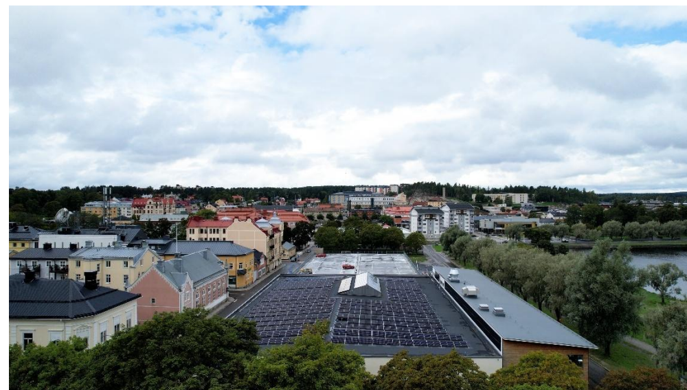
Installation av solcellsanläggningen vid huvudkontoret i Hudiksvall, Sverige.
